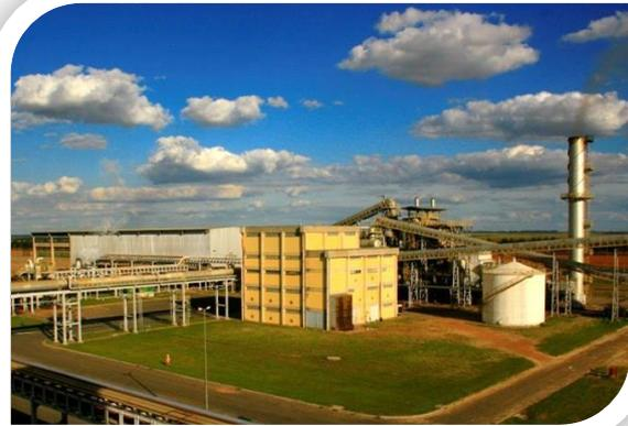
O empreendimento tem por objeto a fabricação de álcool etílico a partir do processamento de cana-de-açúcar, além da produção de energia termoelétrica por meio da queima do bagaço.
